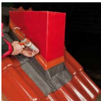
Uszczelnienie zamontowanej listwy wykończeniowej
