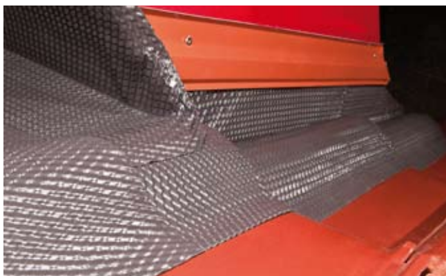
Dokładne wyklejenie obróbki na pokryciu dachowym
