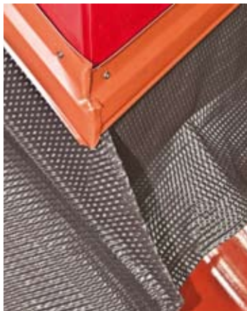
Łączenie elementów obróbki miękkiej na tzw. rąbek
