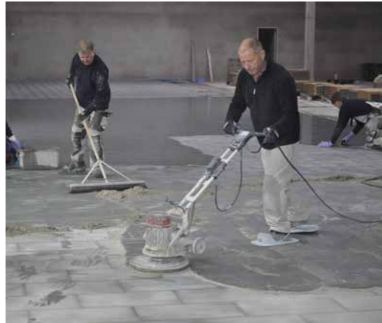
Bardzo wydajne układanie metodą wibracyjną
