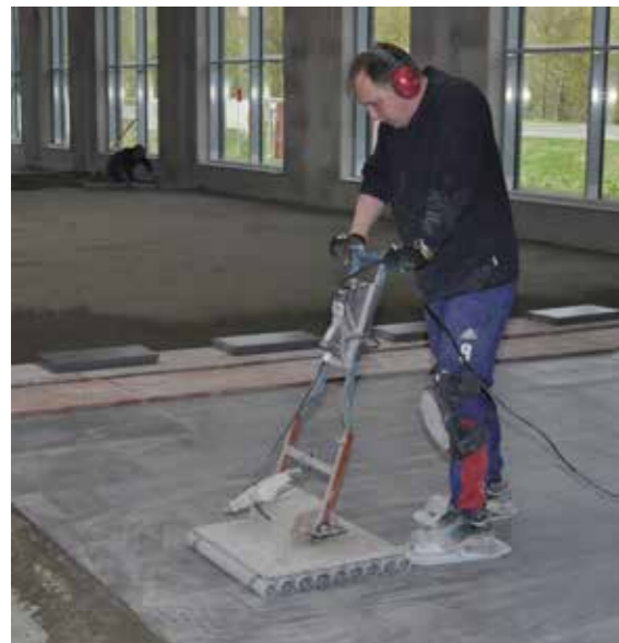
Bardzo wydajne układanie metodą wibracyjną
