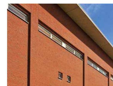
Zakład Uzdatniania Wody we Wrocławiu s. 20
